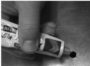
Appliquer une généreuse quantité de silicone autour des trous avant de monter les bases d'adaptateur.
